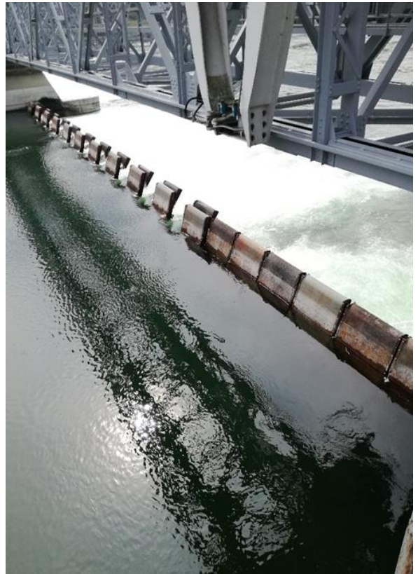
Figura 2: Degrado delle portine di regolazione
